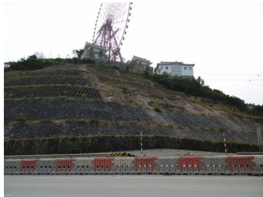
パイロットサイト（国道18号から撮影） (2017年12月2日)
