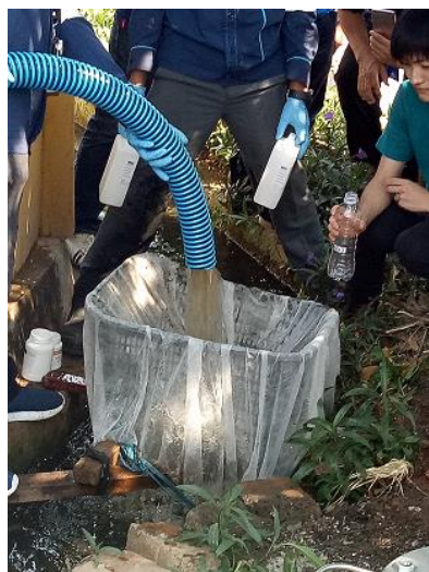
洗浄水の排出開始
