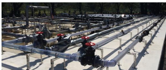
図 2-2 中里建設水理研究開発センター
