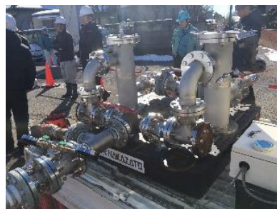
図 2-7 アクアピグの投入装置（左）・回収装置（右）
