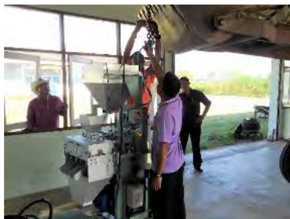
ペチャブリANRDC 「粒造くんミニ」設置作業 (2018年2月)
