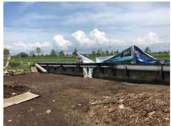
建設中のエアレーション
