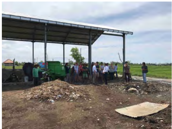
運び込んだゴミの計量を行う建屋
