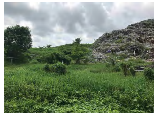
写真 8 ガス抜きパイプと パイプライン
