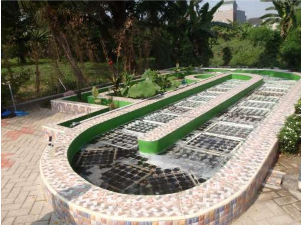
図 3.55 カラワン市で稼働中の曝気処理タイプの浄化施設
