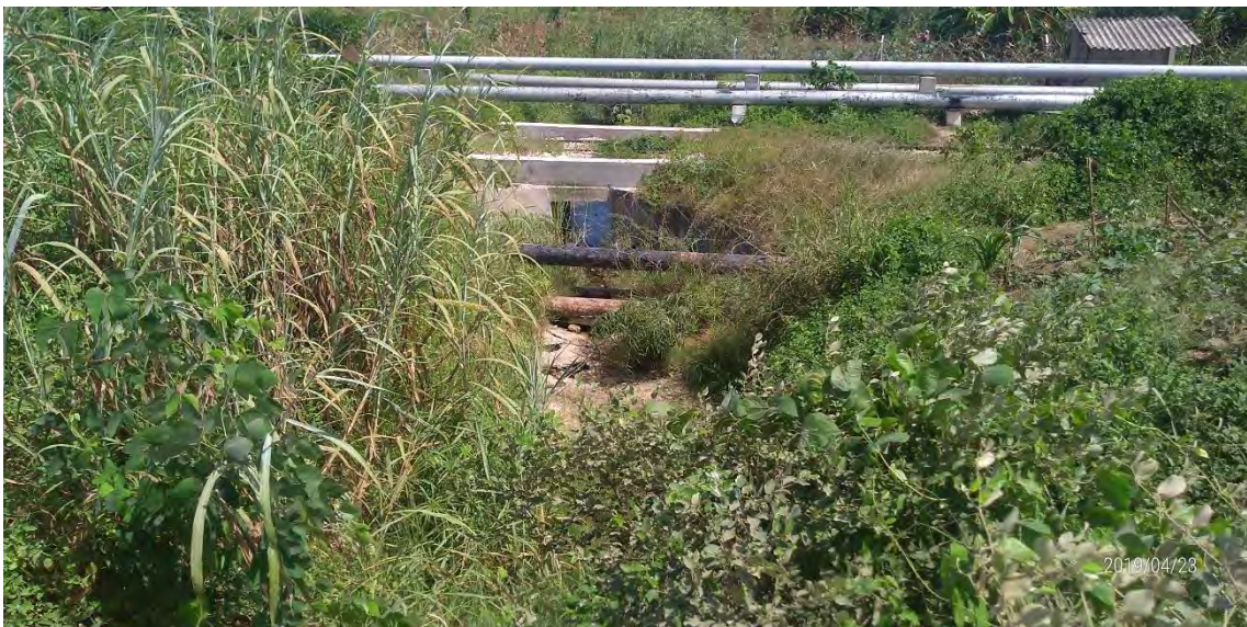
Photo2 : サイト西側の排水管出口から海までの排水路
