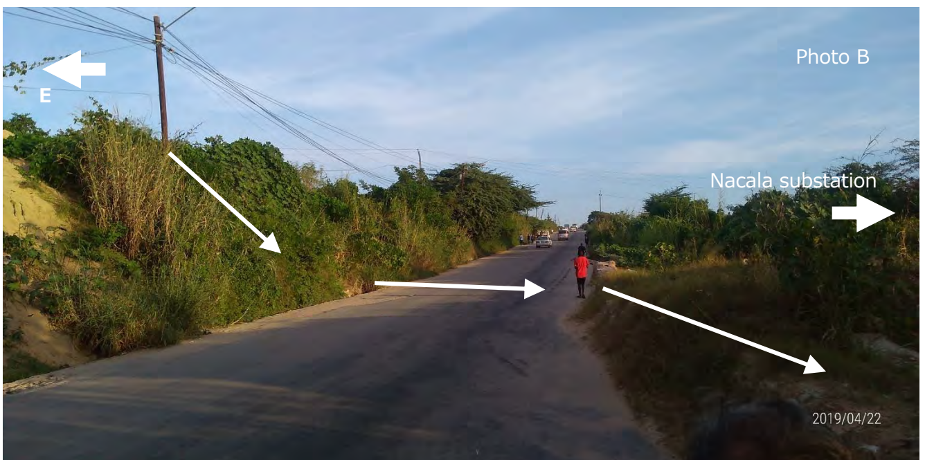
サイト東側の道路。サイトより一段高くなっており、その東側の土地はさらに高くなっていて、浸食された土砂(細かい粒子の砂)が雨水と共に道路上に流れ込み、さらにサイト北東端からサイト内に流入した模様。
