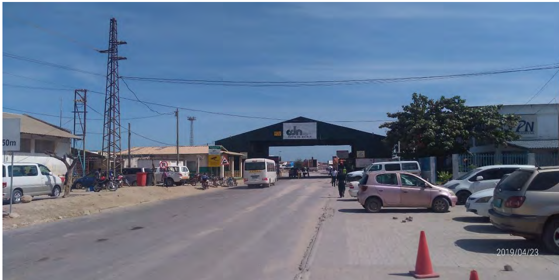
港出入口（ゲート高さ制限 5.5m）
