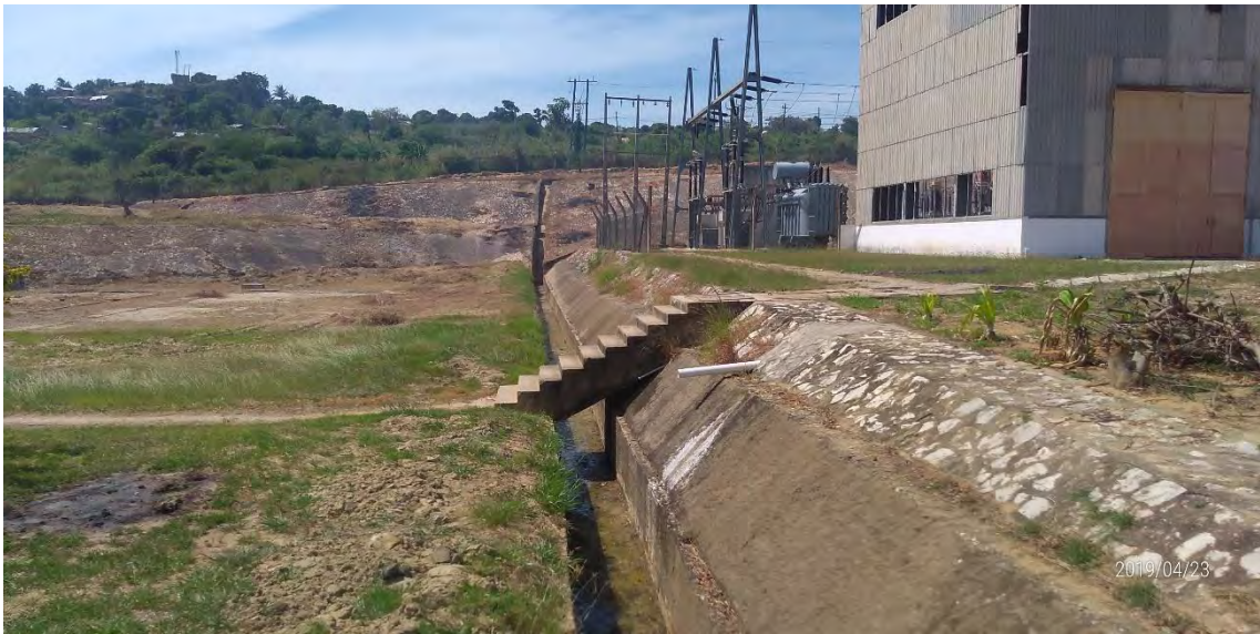
Photo5 : 変電設備北側の排水溝 1
