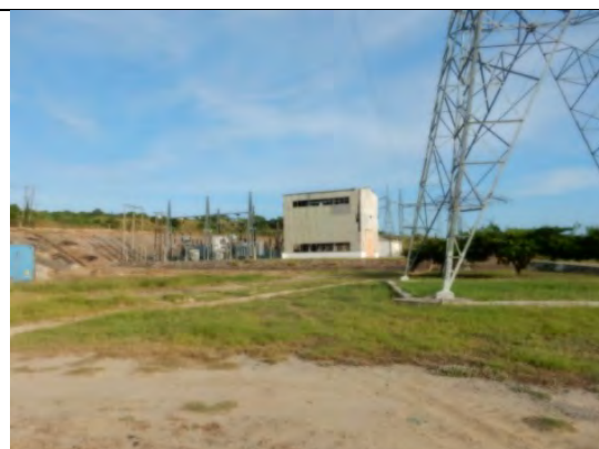
写真-6 ナカラ緊急発電所設置予定エリア、既設鉄塔と既設の変電所メンテナンス建屋方向に撮影
