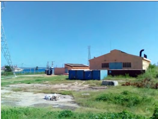
写真-1 ナカラ緊急発電所設置予定エリア、ナカラ湾方向に撮影
