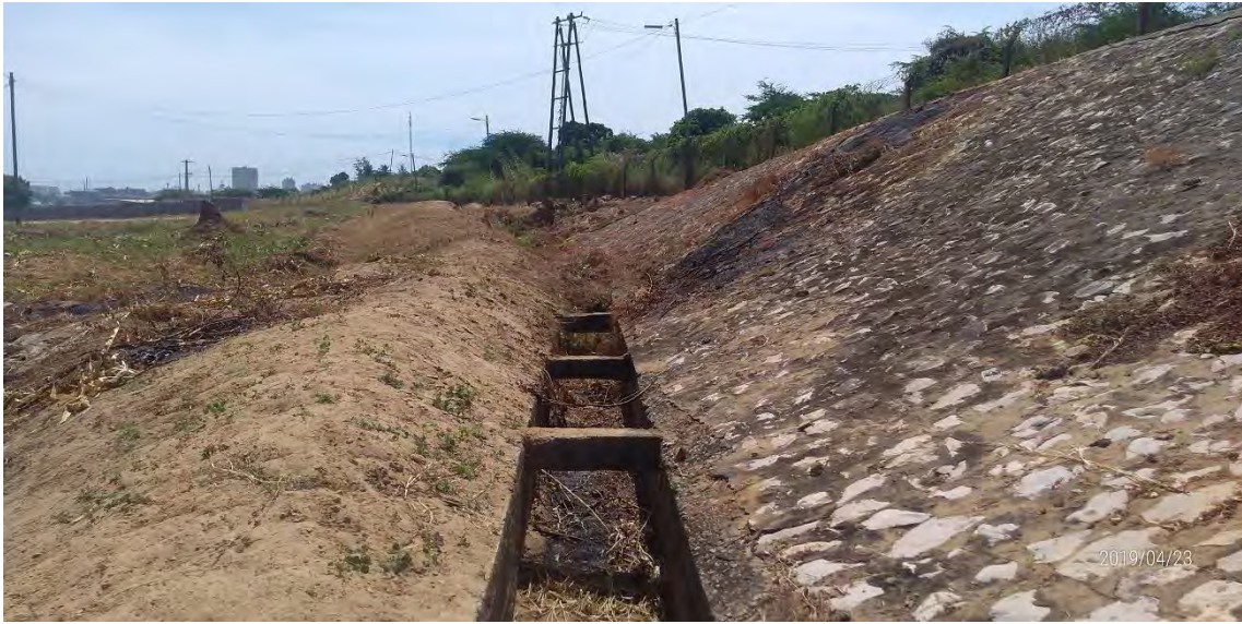
Photo 1 1 : サイト東側の排水溝 3
