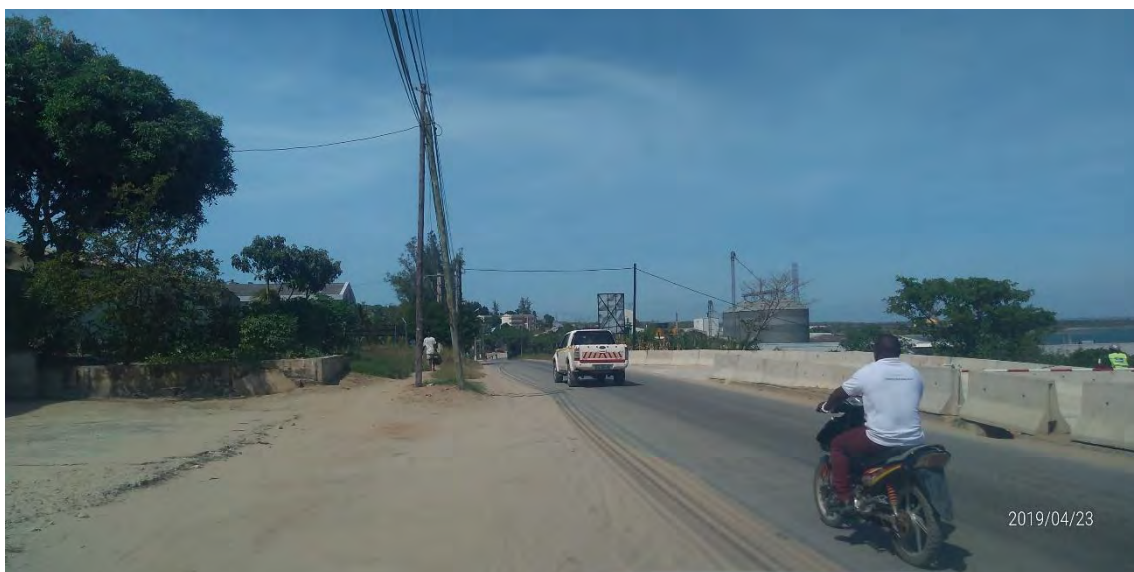
道路を横断する配電線 5（サイトへの舗装路）
