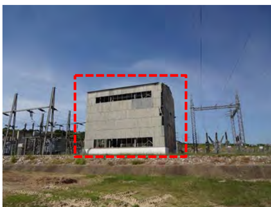
写真 3-5 変圧器メンテナンス用既設建屋
