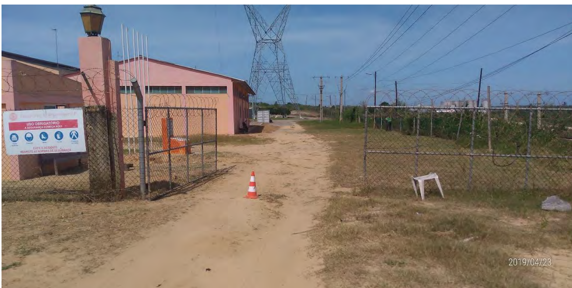
ゲートからタービンエリアへのアクセス路（平坦で砂利舗装が施してある）
