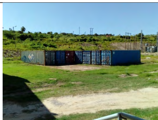
写真-4 ナカラ緊急発電所設置予定エリアの仮置きコンテナ、内陸方向に撮影
