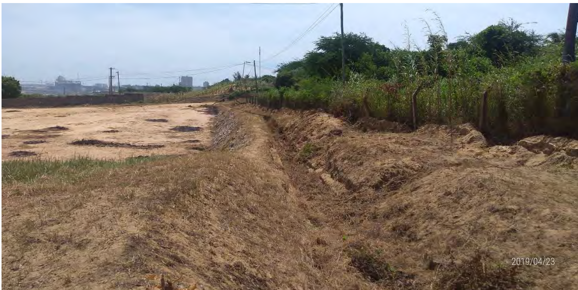
Photo 1 2 : サイト東側の排水溝 4
