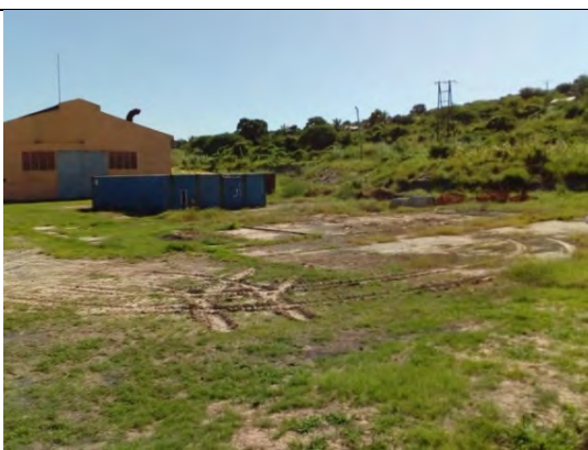
写真-3 ナカラ緊急発電所設置予定エリア、既設変電所制御建屋方向に撮影
