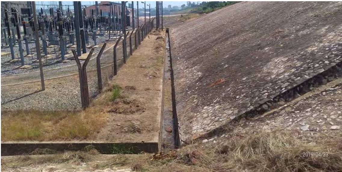
Photo7 : 変電設備東側の排水溝
