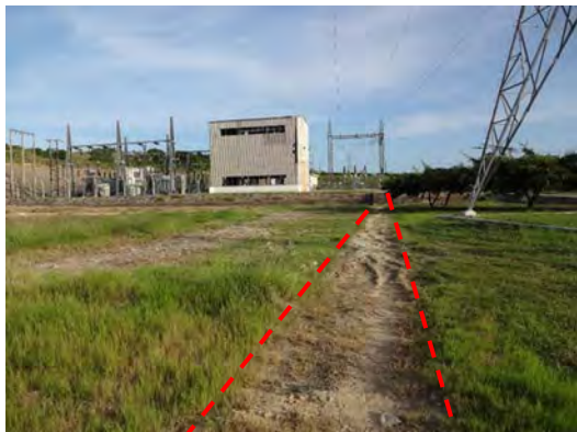
写真 3-6 既設ケーブルトレンチ(1)
