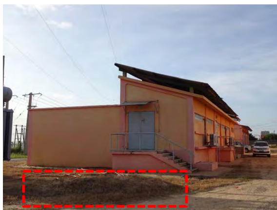
写真 3-3 33kV 開閉器建屋設置可能個所
