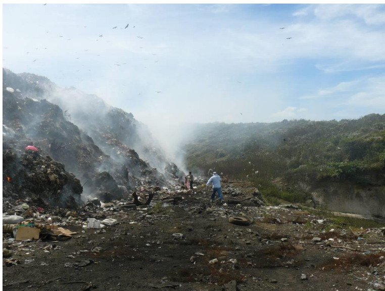
Figura 25. Vista de un talud en combustión en la Chureca
