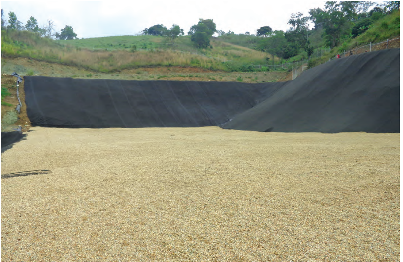
Construcción del vertedero controlao de Villa Altigracia
