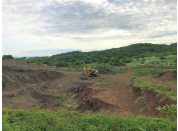
ダハボン市最終処分場建設現場
