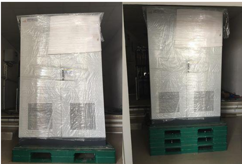
(写真 96 : 1 枚のみのプラスチックパレット上に設置された PCU。写真 97 : 3 枚のパレット上に設置された PCU)
