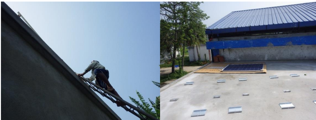
(写真 51: ソーラーパネルを屋根の上に持ち上げている様子。写真 52: 屋根の上に取り付けられたソーラーパネル。)
