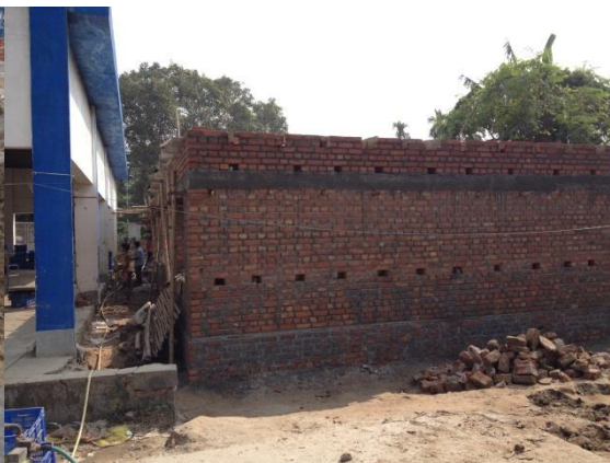
(写真 7：基礎工事、4 段の階段状に高さは 600mm まで積み上げる。写真 8：レンガを積み上げ壁を形成。)
