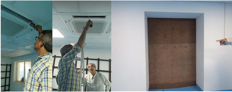
(写真 107：エアコンの吹き出し温度を計測する様子。写真 108：ドアの代わりに取り付けられたベニア板。)
