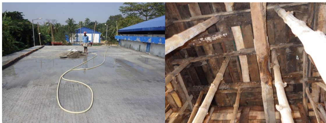
(写真 11：打設したコンクリートを水で冷却。写真 12：室内から竹柱で屋根を支える。)
