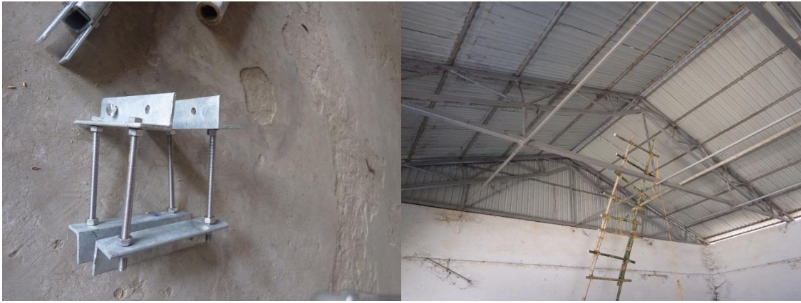
(写真 72 : 屋根の補強工事に使用される金具 写真 73 : 補強を行う倉庫の垂木 (三角部) )
