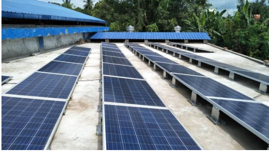
倉庫屋根 ソーラーパネル設置後
