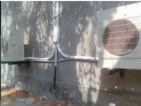
(写真 21： 倉庫内に設置されたエアコンの室内機。写真 22： 倉庫の南側の壁に設置されたエアコンの室外機。これも水害と盗難対策用に、地面より高い所に設置した。)
