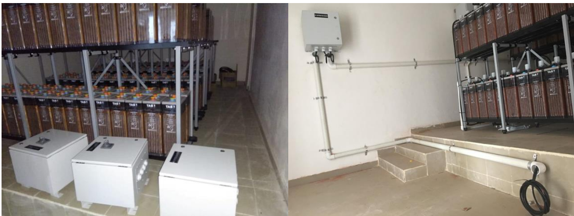
(写真 70、71：Mini DCDB(配電盤)の配線作業の様子)
