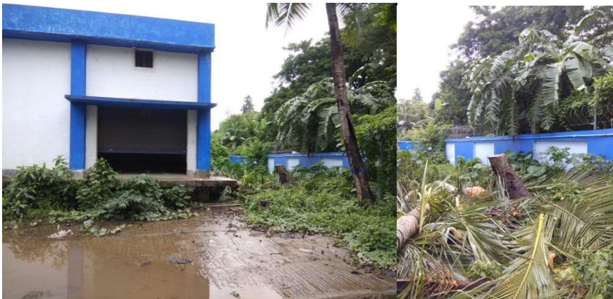
(写真 94、95 : Go-Down 西側の椰子の木を伐採した様子)
