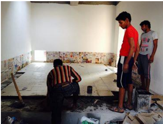
(写真 23、24： 蓄電室の防酸タイル張り作業の様子)
