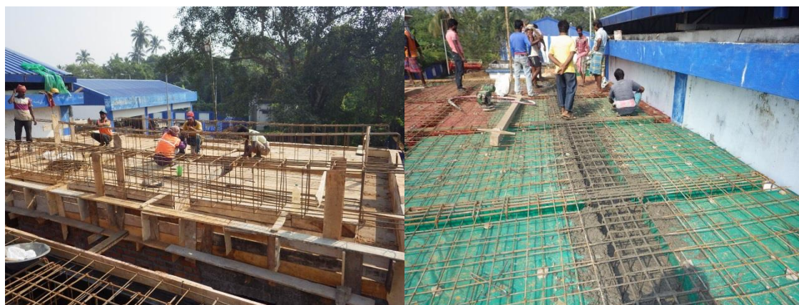
(写真 9：屋根工事、木枠の上に格子状の鉄筋をはめ込む。写真 10：木枠にコンクリートを流し込む。)
