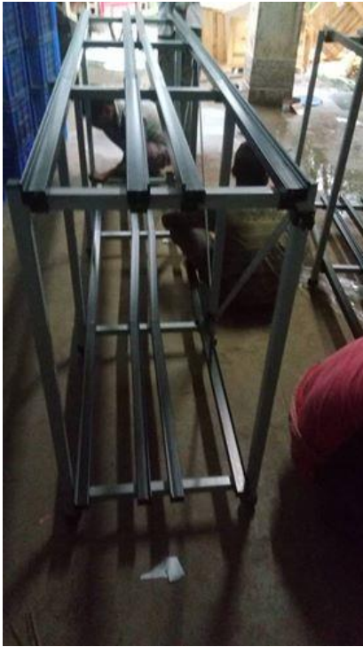
(写真 65:ラックを組み立てている様子)
