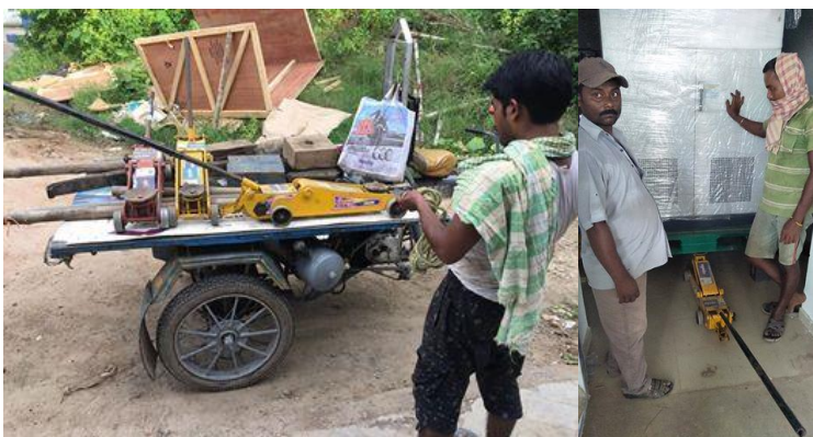
(写真 98、99 : 3 枚のパレット上にジャッキで PCU を持ち上げ設置する様子)
