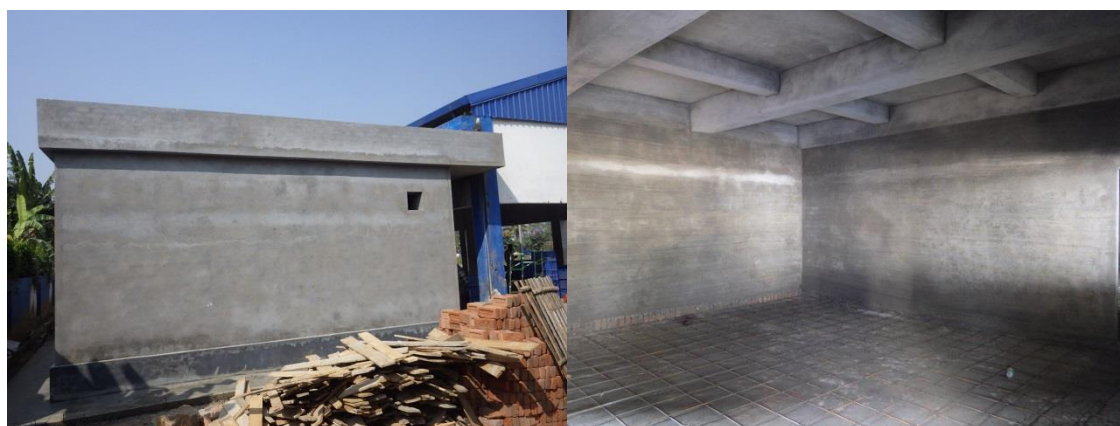
(写真 13：外装のモルタル塗装。写真 14：内装のモルタル塗装と床に鉄筋が施される。)
