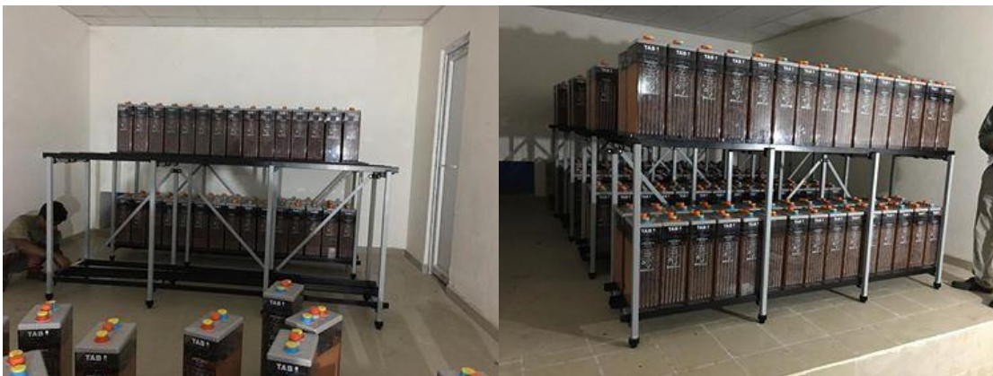
(写真 66 : バッテリーのラックを組みながら格納している様子。写真 67 : 4つの全てのラックが完成し、240 台全てのバッテリーを収めた様子。)
