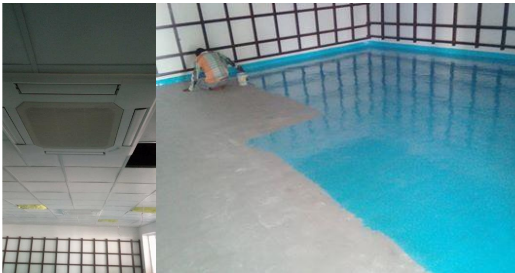
(写真 29：ジプトーンボードを貼った天井の様子。写真 30：アクリル樹脂エマルジョンの塗料で床面を塗装している様子。)
