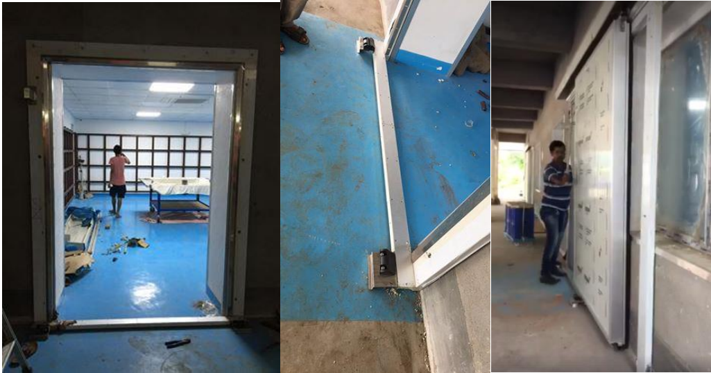
(写真 113：ドアのフレームの取り付けが終わった様子。写真 114：ドアのフレームの下側の段差の様子。写真 115：ドアパネルの取り付けが終わった様子。)
