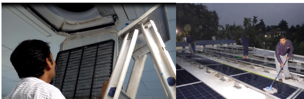
(写真 131: エアコンのフィルター清掃の様子、写真 132: ソーラーパネル洗浄の様子)
