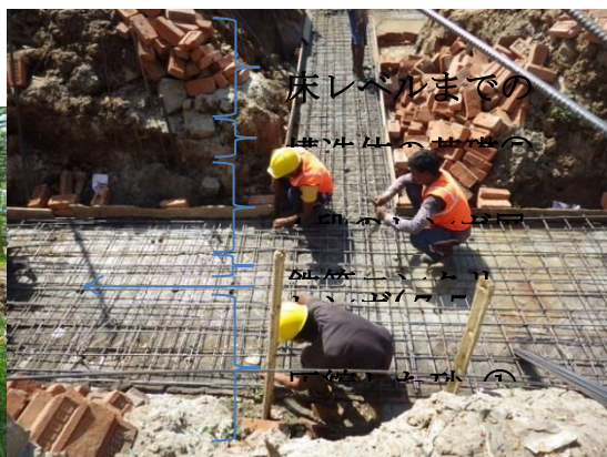
(写真 5：基礎工事、土壌の掘削作業風景。 写真 6：レンガを敷きコンクリートと鉄筋、さらにコンクリートを流し込む。)
