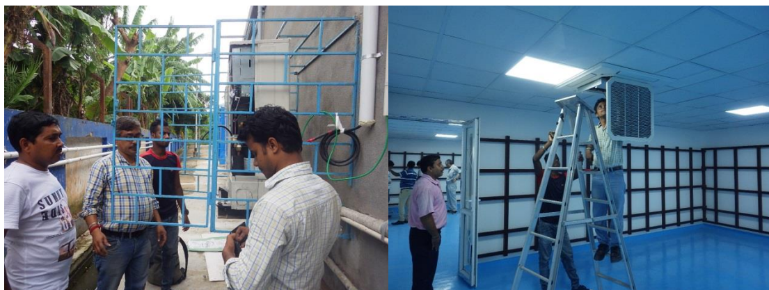
(写真 105 : エアコンの室外機の電気配線工事の様子、写真 106 : エアコンの室内機の電気配線工事の様子)
