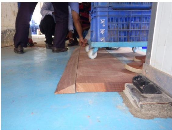
(写真 116：ドアの段差解消プレートを取り付けている様子)
