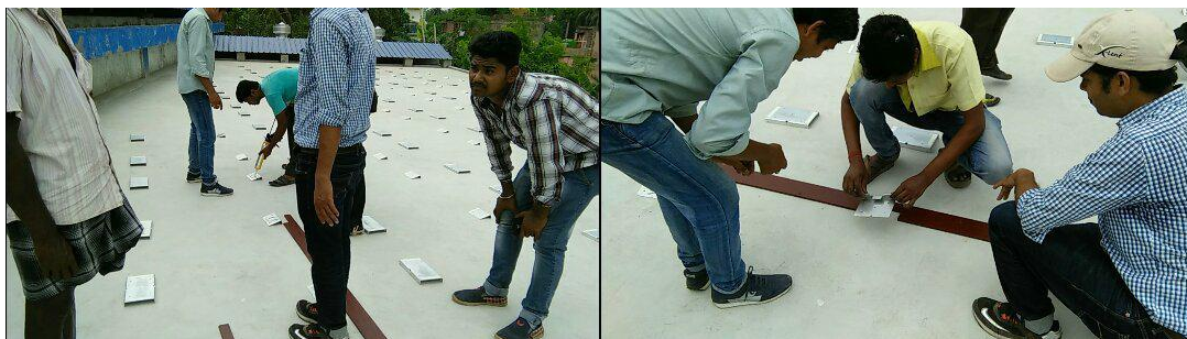
(写真 44、45：並べた金具にコーキングガンで接着剤を塗布し貼り付けている様子)
