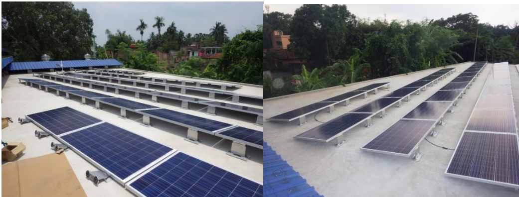
(写真 59: マグネット部を装着している様子。写真 60: 42 枚のソーラーパネルが全て装着完了した様子。)
