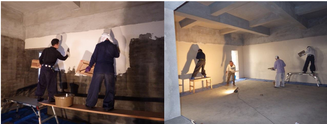
(写真 17、18：田中建設および現地作業員による漆喰塗装の様子)
