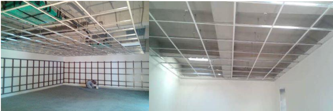
(写真 27、28：吊り天井の金属のフレームとそれを吊るすワイヤーが取り付けられた様子)
