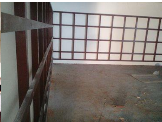
(写真 25： 倉庫にて漆喰塗装した壁に“荷ずり”の縦木を取り付けている様子。写真 26：“荷ずり”が完成した様子。)
