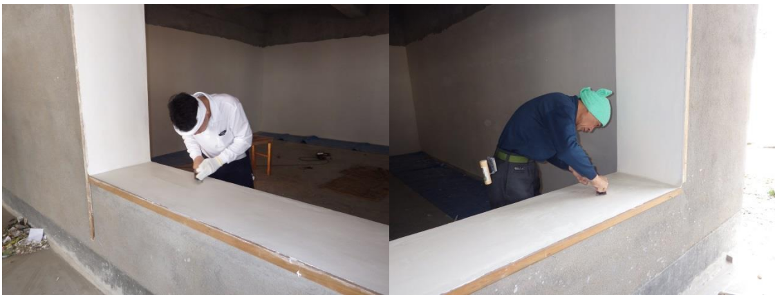
(写真 19、20：窓枠に漆喰塗装を施している様子)
