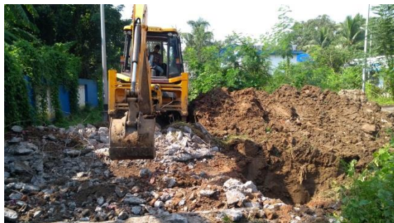
(写真 5：基礎工事、土壌の掘削作業風景。 写真 6：レンガを敷きコンクリートと鉄筋、さらにコンクリートを流し込む。)
