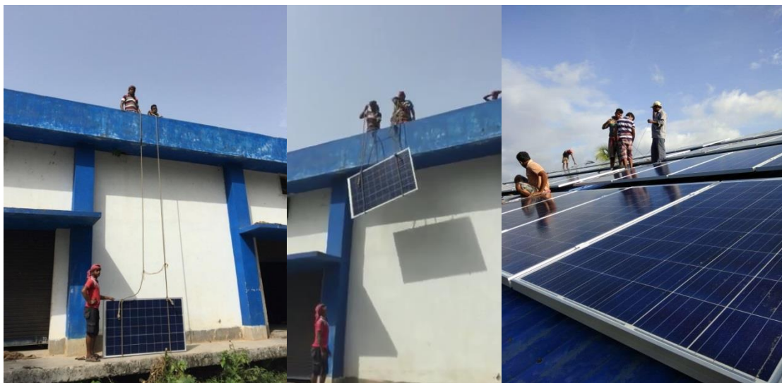
(写真 78、79:ソーラーパネルを屋根に上げる様子。写真 80: 設置されたソーラーパネルの様子。)
