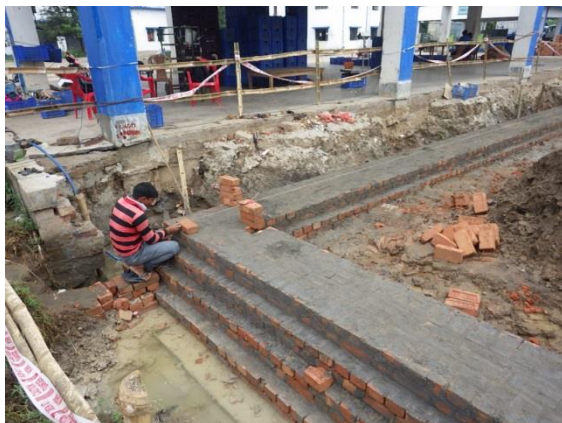
(写真 7：基礎工事、4 段の階段状に高さは 600mm まで積み上げる。写真 8：レンガを積み上げ壁を形成。)
