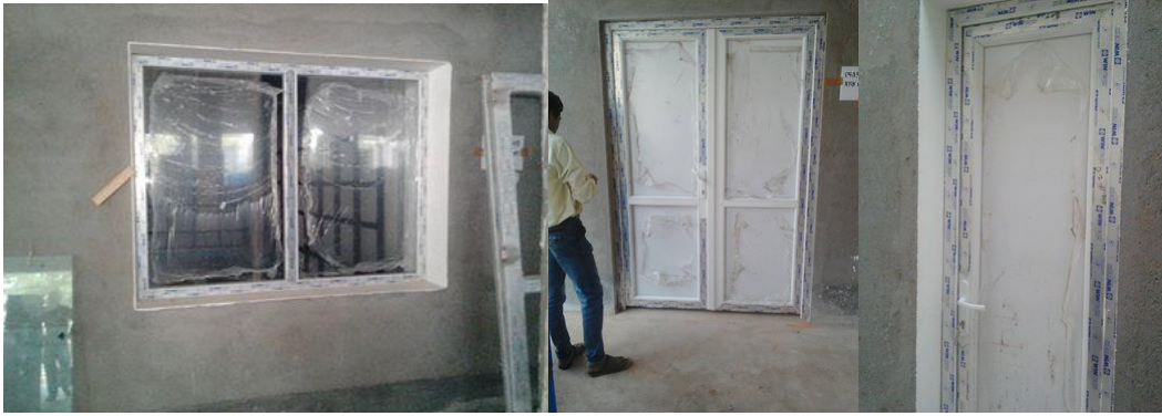
(写真 33 : 倉庫に取り付けられた窓、写真 34 : 蓄電室のドア、写真 35 : 倉庫の裏口のドア)
