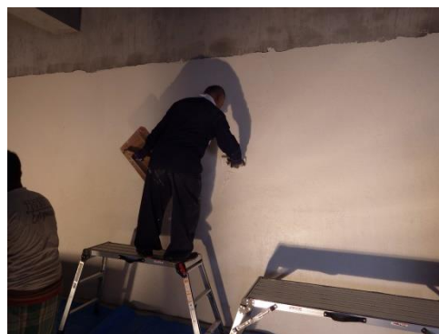
2018年2月 漆喰塗装作業
