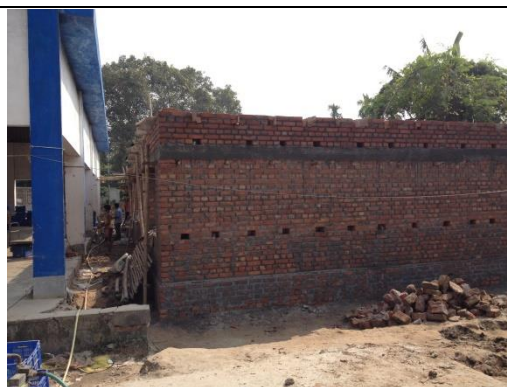
2017年12月 建設工事
