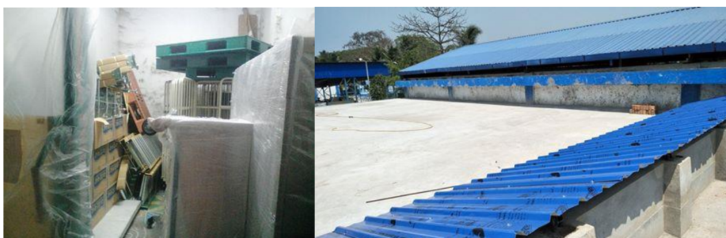
(写真 31：日本から輸出した機材。写真 32：蓄電室と倉庫の間の廊下の屋根を設置した様子。)
