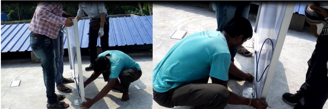
(写真 55、56: 金具の付いたソーラーパネルを陸屋根の金具に設置している様子)
