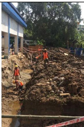
2017年11月 基礎工事
