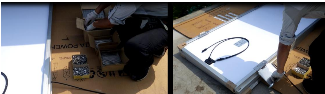
(写真 53、54: ソーラーパネルに金具を取り付ける様子)
