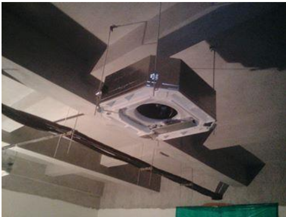
(写真 21： 倉庫内に設置されたエアコンの室内機。写真 22： 倉庫の南側の壁に設置されたエアコンの室外機。これも水害と盗難対策用に、地面より高い所に設置した。)
