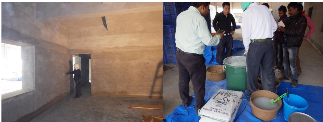
(写真 15：漆喰塗装前に塗装面に接着増強剤を塗布。写真 16：漆喰の材料を攪拌機で水と混ぜ合わせる様子。)
