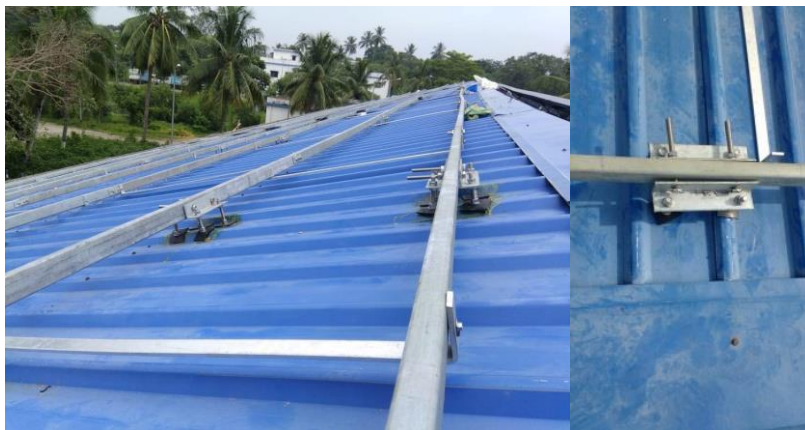
(写真 76: 屋根の上の母屋材。写真 77: 屋根の金具、垂木に溶接されたものと 90 度交差し、母屋材を支えている。)
