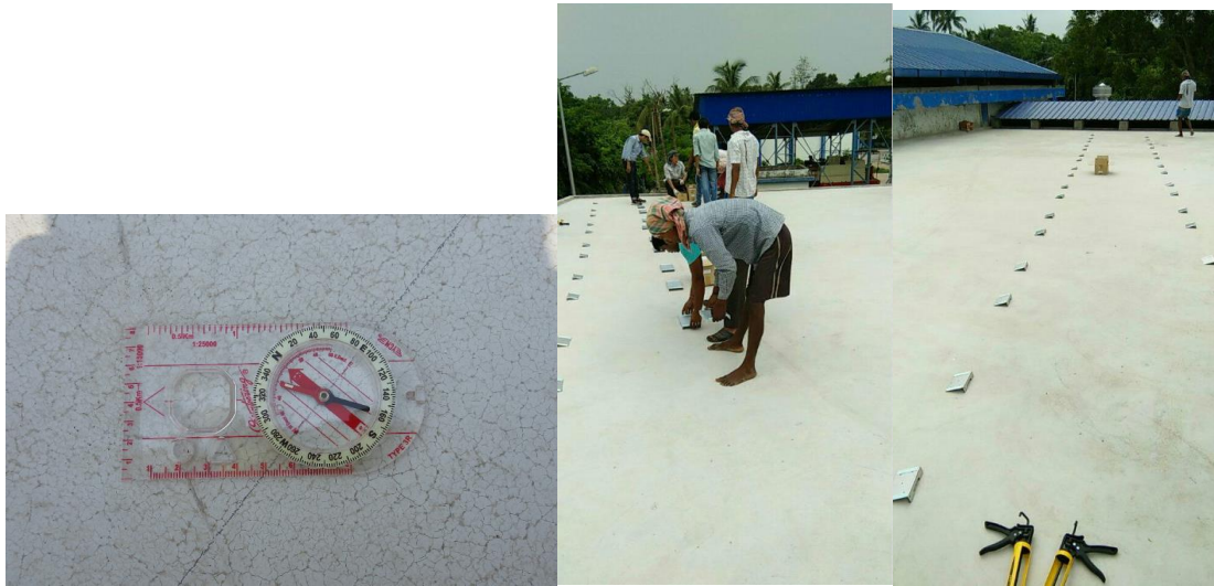
(写真 41：真南より 23 度傾けられた位置決め作業の様子。写真 42、43：屋根に接着する金具を並べている様子。)
