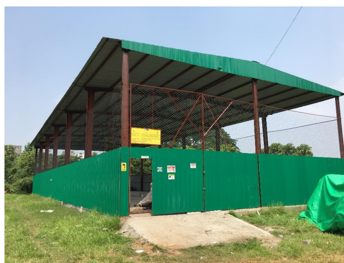
図 8 完成した工場建屋
