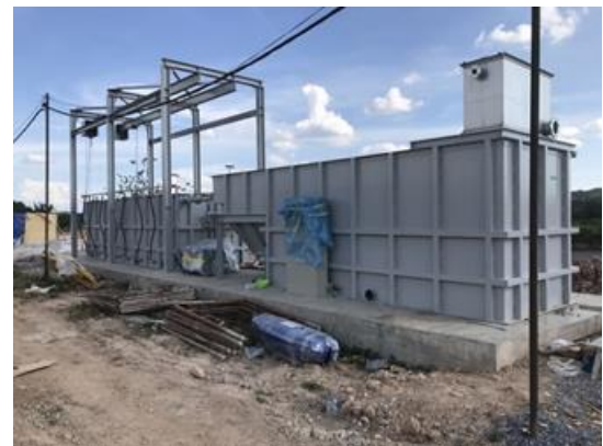
設置・組立が概ね完了した排水処理装置 (2018年3月)
