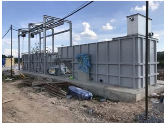
設置組立が概ね完了した排水処理装置
