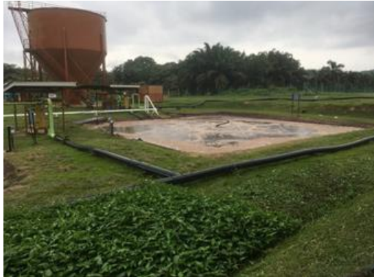
H 株式会社の AQUARATOR を導入した好気性処理
