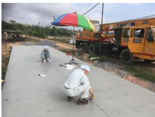
設置前の墨出し作業
