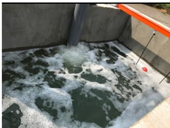
調整槽内へのポンド水流入状況
