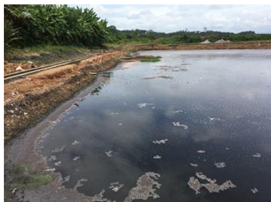
KPSB パーム油工場のラグーン処理
