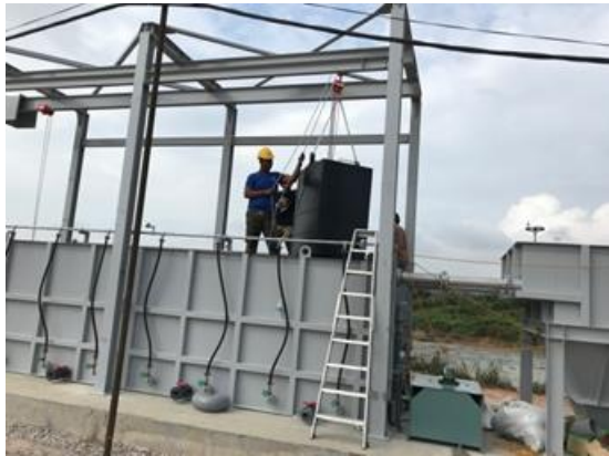
充填カゴの格納作業
