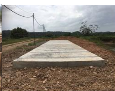
設置箇所（整地・基礎工事後）
