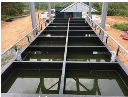
水道水による通水試験状況
