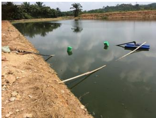
取水施設の設置工事
