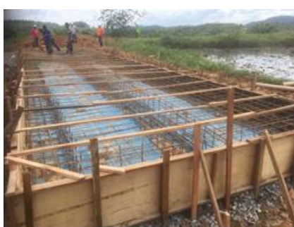
コンクリート基礎工事
