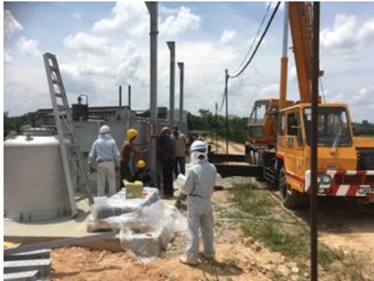
クレーンによる排水処理装置の設置
