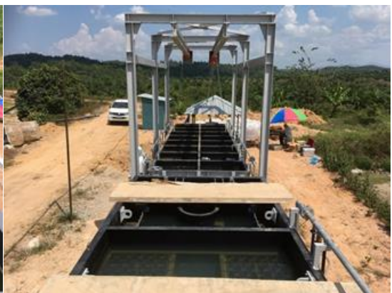
水道水による通水試験状況
