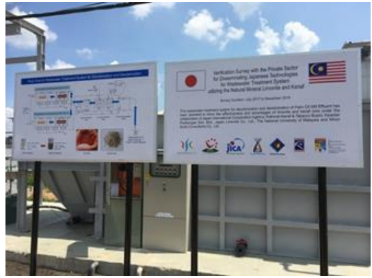
排水処理装置前の看板 （2018年4月）
