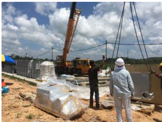
クレーンによる排水処理装置の設置 (2018年3月)
