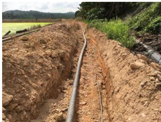
流入管・流出管の設置工事
