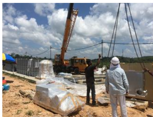
クレーンによる排水処理装置の設置
