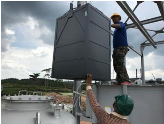
充填カゴの吊り上げ作業
