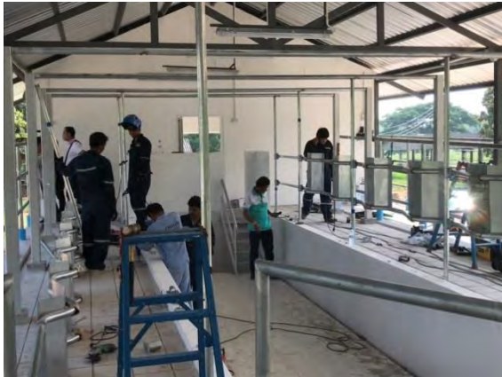
サケオ試験場機材設置風景 (2019年1月)
