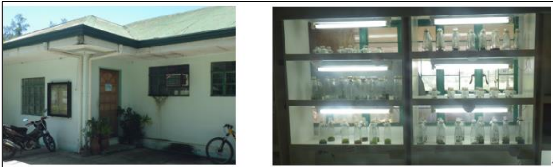
図 2-5 2001年に建設されたMMSUのティッシュカルチャーラボラトリー (出所：JICA調査団撮影)
