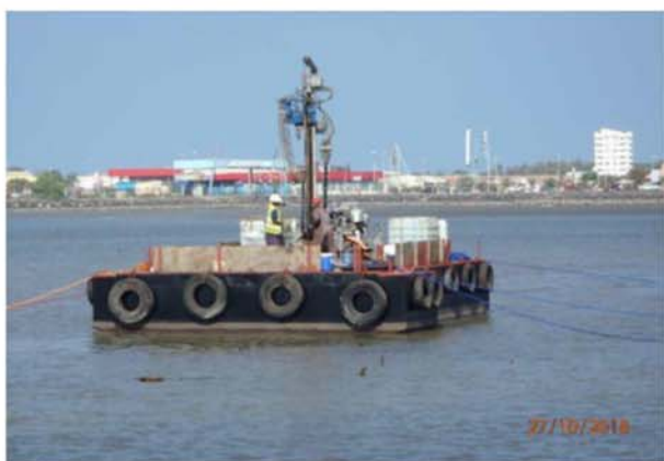
土質調査実施状況:ジブチ港
