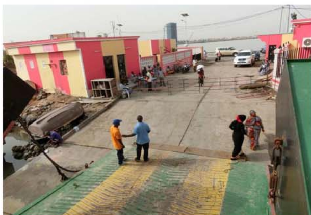
ジブチ港現行フェリーターミナル部
