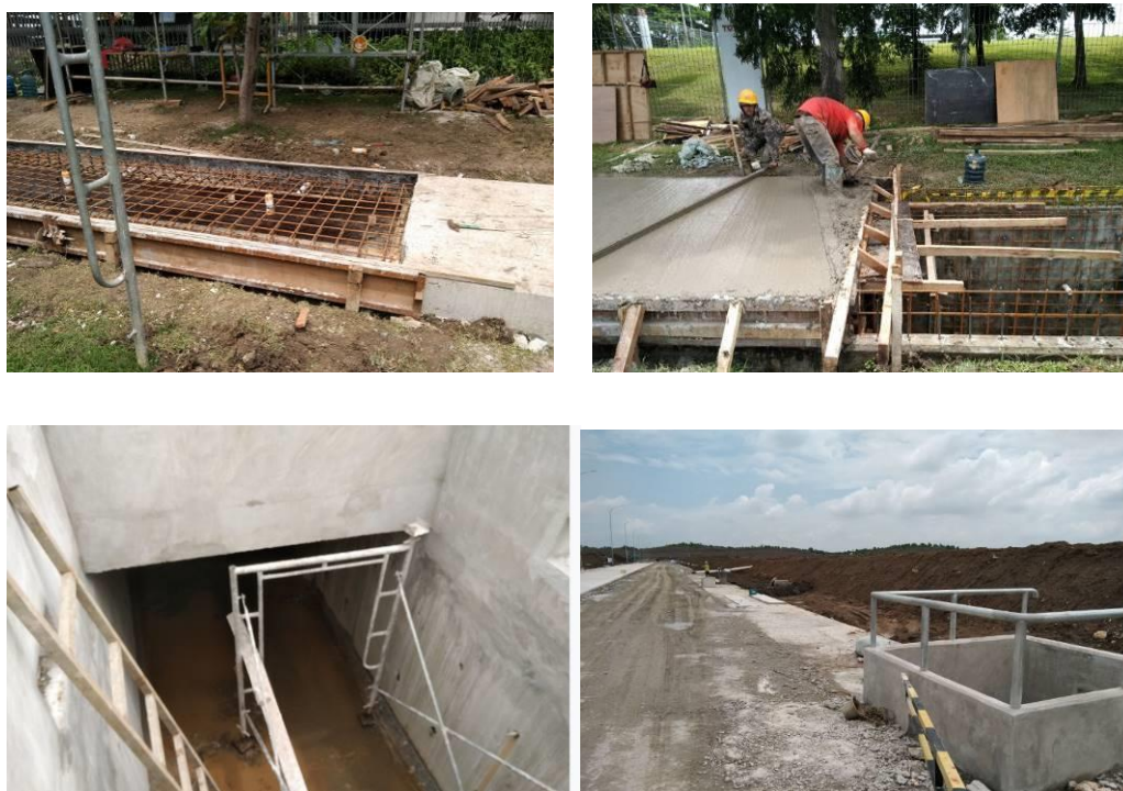
図 10 KIIC における雨水排水溝のボックスカルバート化の工事及び施工状況
