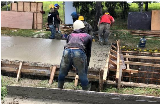
KIIC 内の側溝制作の様子 (3/13)
