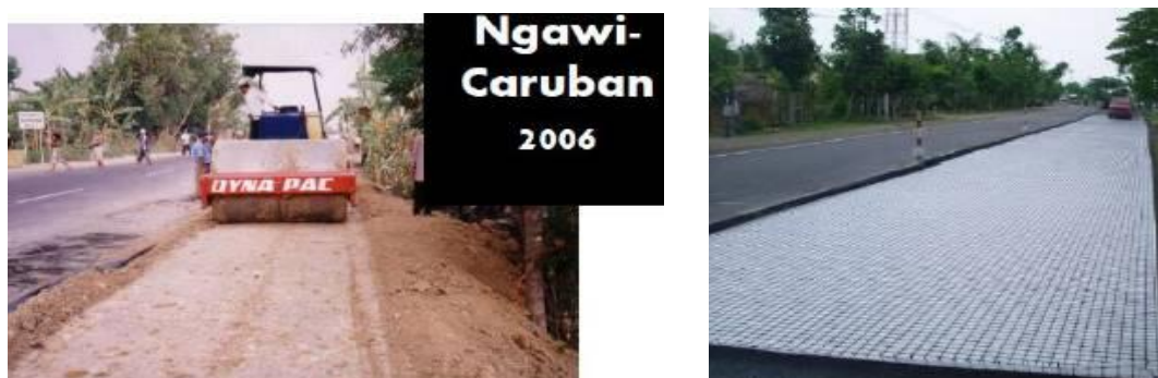
図 18 東部ジャワ州マデウン地区での膨張土による道路被害の補修作業②
