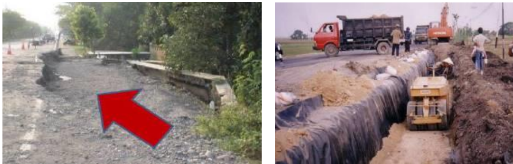
図 17 東部ジャワ州マデウン地区での膨張土による道路被害の補修作業①
