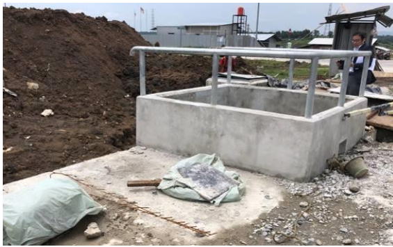
KIIC 内で建設中の側溝。膨張圧で破壊されないように角型となっている (3/13)
