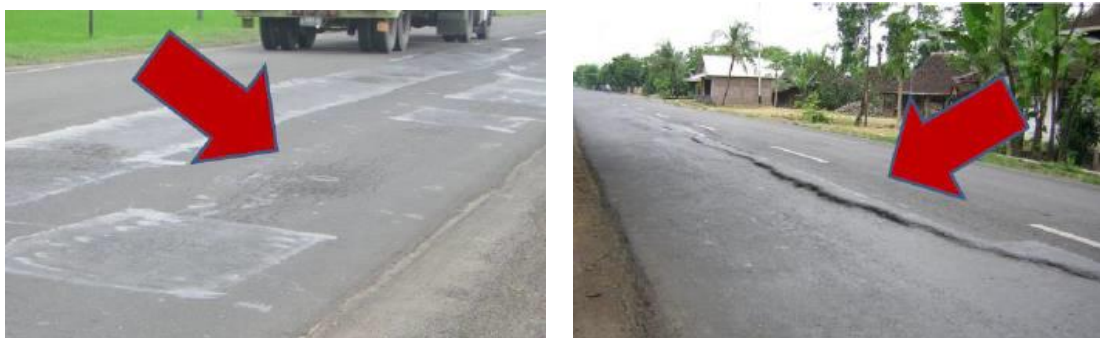
図 16 東部ジャワ州マデウン地区での膨張土による道路面の沈下と隆起の状況
