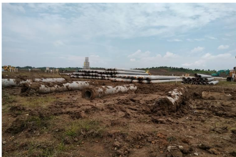
図 12 工業団地敷地での膨張土対策
