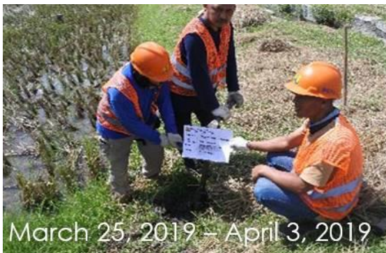
現地での膨張土の採取作業状況 (7/30 IRE 提供)
