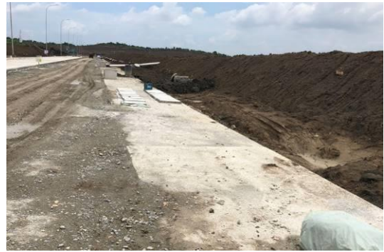
KIIC 内の側溝。蓋も一体型の形状で現場打ちのコンクリートで対応 (3/13)
