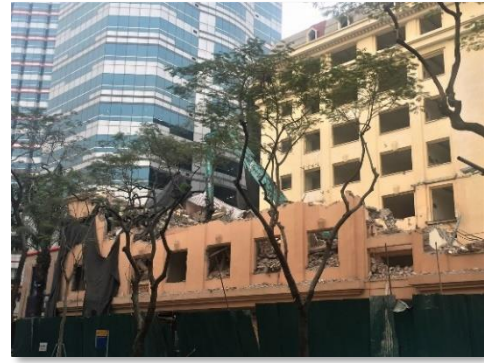
2019.3 ハノイ市内の解体現場
