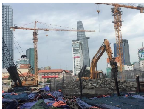
2019.6 ホーチミン市内の解体現場
