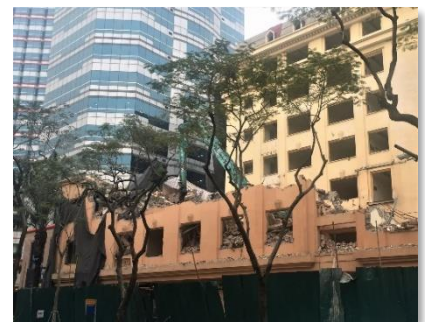
図 2-4 ハノイ市内の解体現場
