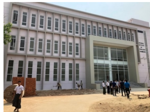
NIMM正面入口外観（舗道整備中）
