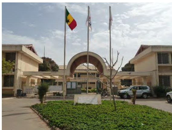
施設入口外観
