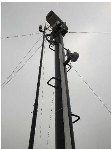
赤外線カメラの設置状況
