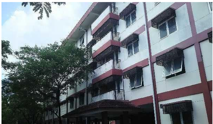
赤外線カメラを設置した学生宿舎
