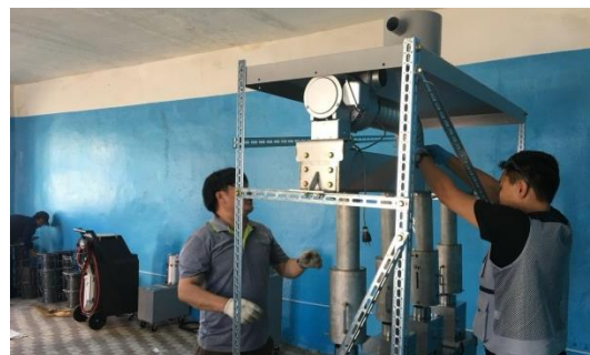
再生装置据付 (第3バス) 2018年8月
