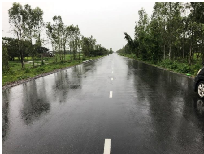
図 1-4 ADB プロジェクトによって建設されたマウビン～ピャーポンハイウェイ
