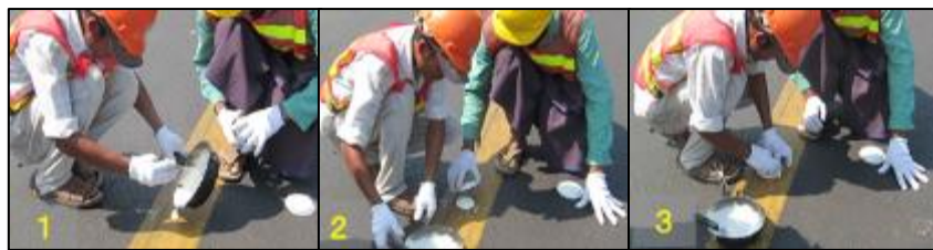
図 2-4 容易な施工方法（ミ国での施工の様子）
