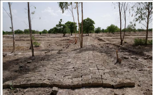
A la fin des travaux
