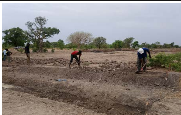
Ajustement du ramblai après le compactage
