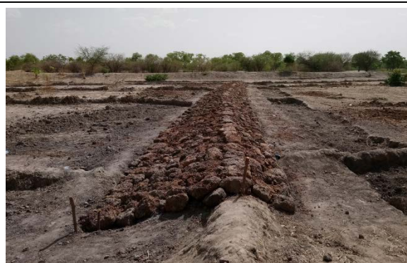
Après les travaux
