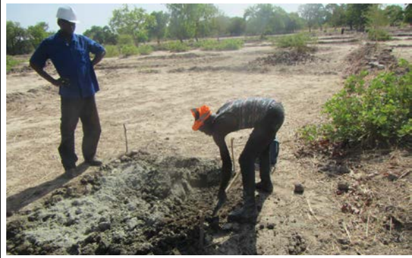
Travaux de mélange de ciment
