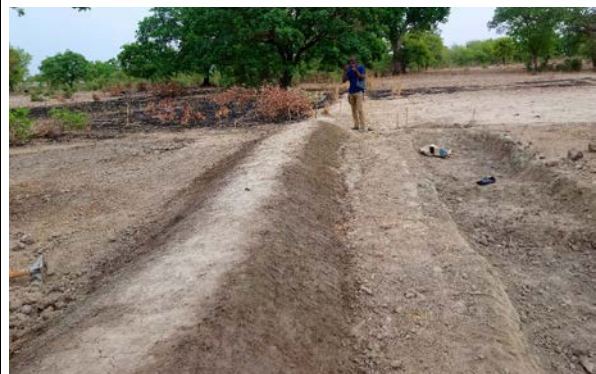
A la fin des travaux
