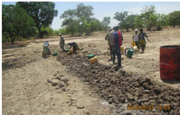
Arrosage de la terre excavé (Ajustement du taux d'humidité pour le ramblayage)
