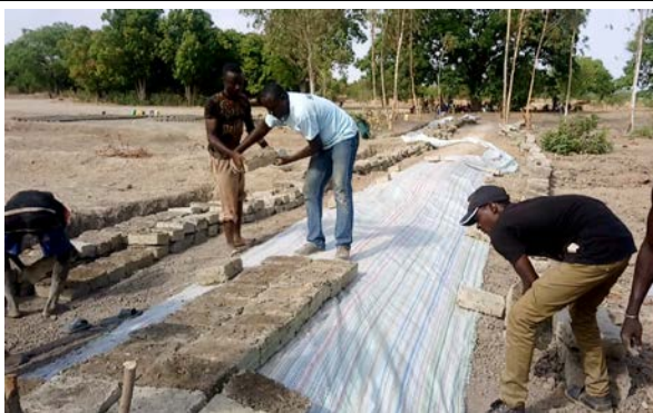
Pose des briques sur la feuille géotextile
