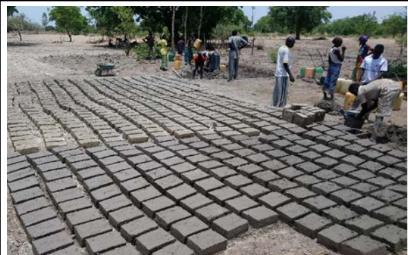
Séchage des briques en banco amélioré
