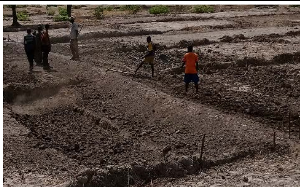
Diguette après remblayage
