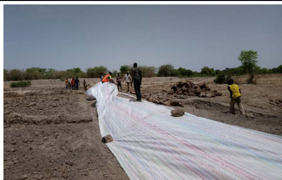
Pose du géotextile
