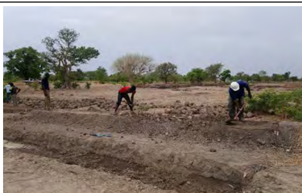
締め固めた盛土の成形作業
