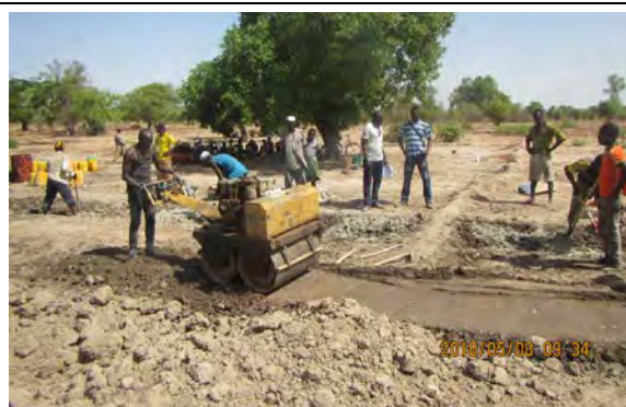
セメントを混合した土による盛土
