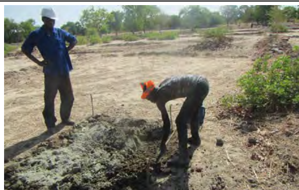
セメントの混合作業
