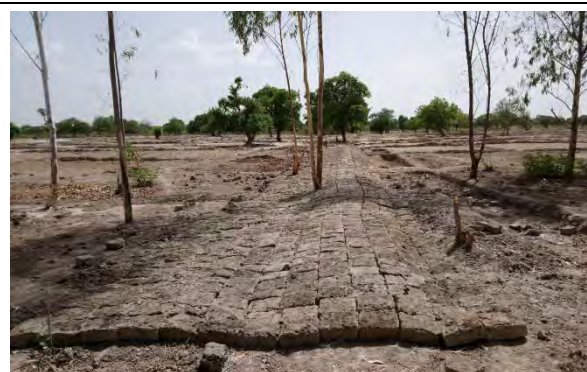
完成後の状態
