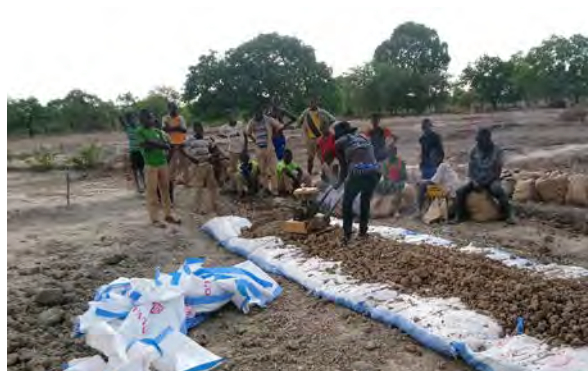
土のう間の埋め戻しと締固め作業
