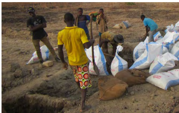
土のうの制作
