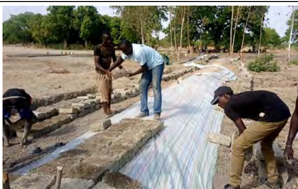
シート敷設後にブロックの施設
