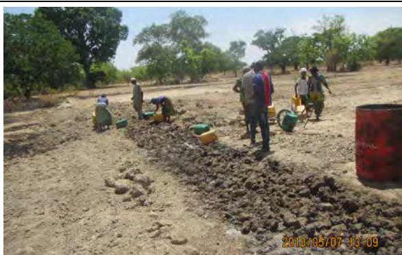
掘削土への散水(盛土のための含水調整)
