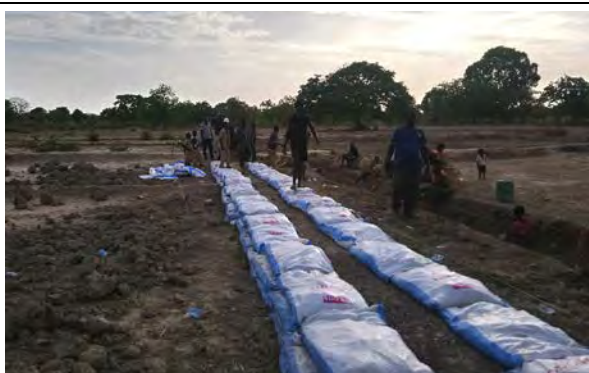
土のう敷設(2段目)
