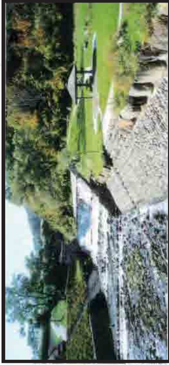
自然石配水溜り・階段状に構築した築堰工
