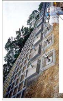
【Landslide】 Prevention works (1/2)
