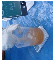
樹脂、硬化剤の混合
