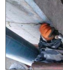
座金・シールの撤去
