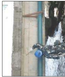
施工面の処理
