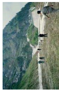
Направляющие сооружения Изменяют направление лавины
