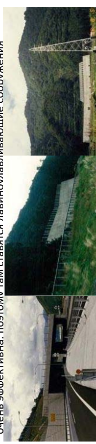
Снегозащитная галерея Направляет течение лавины вниз по склону
