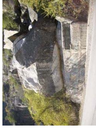
Бетонная защита у подножья (дорога Бишкек-Ош ДЭУ-23)
