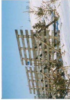
Пример деревянных защитных заборов (тип с коэффициентом просветности 50%, с довольно большим шагом)
