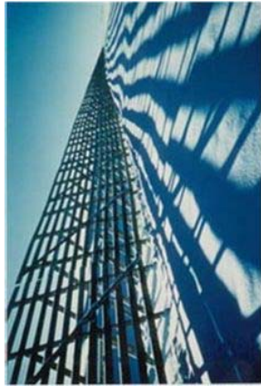
Пример деревянных защитных заборов (тип с коэффициентом просветности 50%, с довольно большим шагом)
