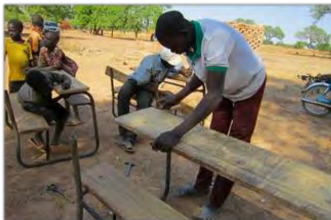
COGESによる学校設備の修繕作業
