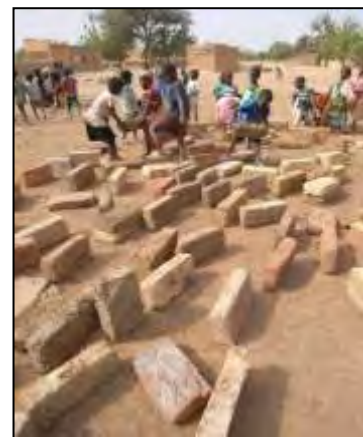
COGESの学校活動計画にて学校給食の台所を建設中。子供たちもお手伝い!
