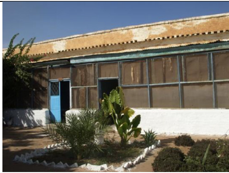
東ジャジーラ・ロカリティ助産師学校
