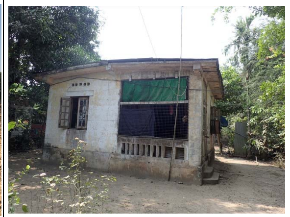
写真 4: 計画サイト B ゾーン 教育省職員の家族 8 世帯の既存住居があり、先方負担により引っ越しと既存建物の撤去作業が実施される。
