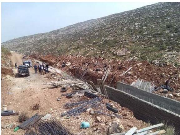
ベイトアナン・コントロールドダンプサイト（2018年4月）の雨水排水カルバートの施工風景。
