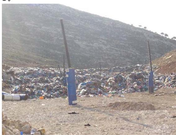
ベイトアナン・コントロールドダンプサイトの状況（2018年11月）。雨水排水カルバート工事・遮水工が完了し、一部ごみの搬入を受け入れている。
