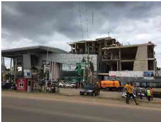
写真1 沿道に建設中の近代的なビル
