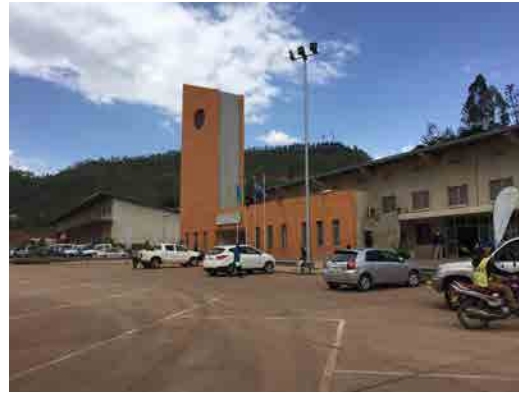
本事業により整備された OSBP 施設
