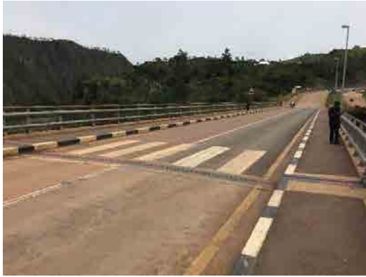
本事業により整備されたルスモ橋
