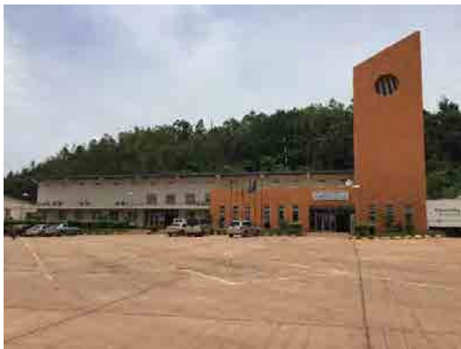
写真1 OSBP 施設 総合管理事務所
