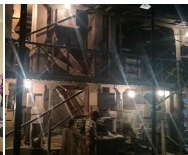
電気が不可欠な製粉工場 (シレット)
