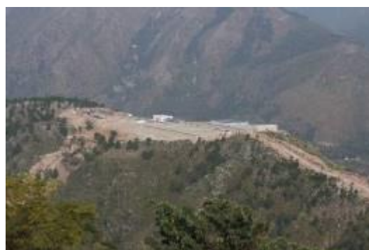
写真1. 新設された表流水システムの浄水場（2015年7月撮影の遠景）
