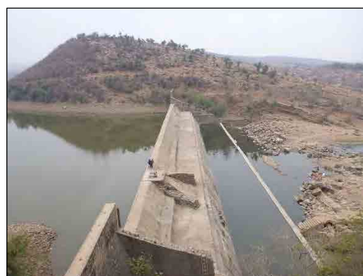
本事業が改修を行ったダム
