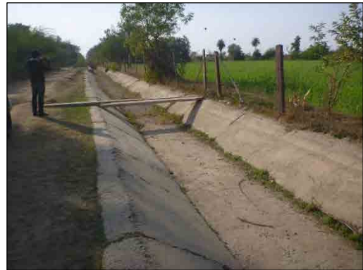
清掃された水路（本事業対象区間）
