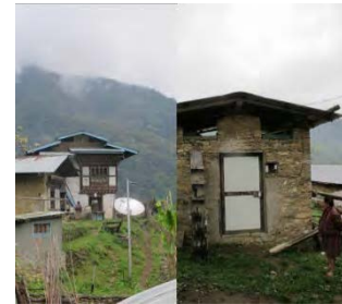
写真 4: トンサ県ランテル・ゲオッグ 左: 本事業で電化された住宅 右: じゃがいもの保管倉庫、電力供給で室温をコントロール
