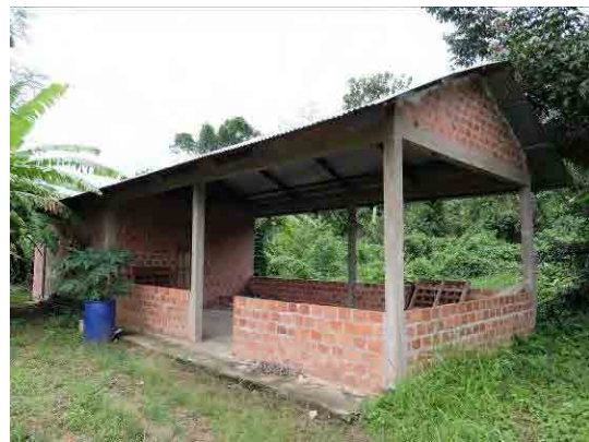
本事業のF/U協力により提供された籾貯蔵庫と乾燥台（ベジャ・アルトゥーラ集落）
