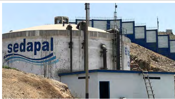
本事業が修復した配水池
