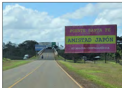
取付道路と橋梁
