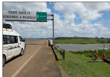
FOMAV による側溝の清掃作業
