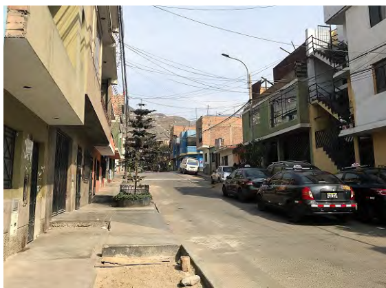
上下水道修復が行われた街路
