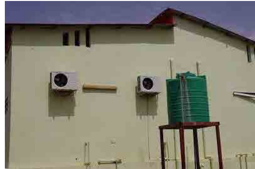
事後評価時に改修されたスキ・ローカリティ 病院産科棟
