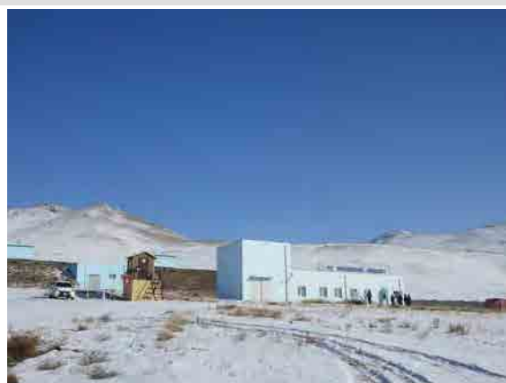
塩素消毒・操作棟及び配水池
