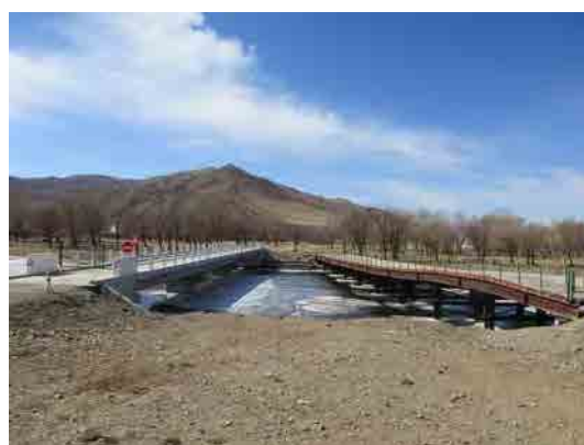
維持管理用橋梁（左側）と仮設橋
