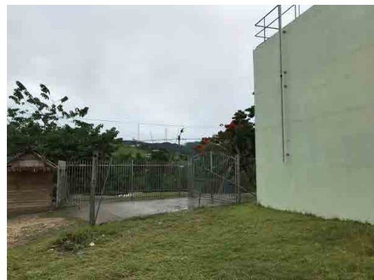
旧配水池内に設置された、タサへのポンプ 施設を囲む古いフェンス
