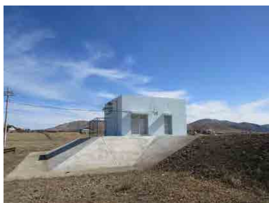
本事業で建設した井戸
