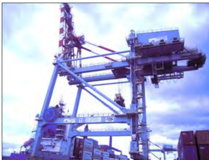
バタンガス港ガントリークレーン
