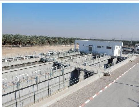
建設された下水処理施設
