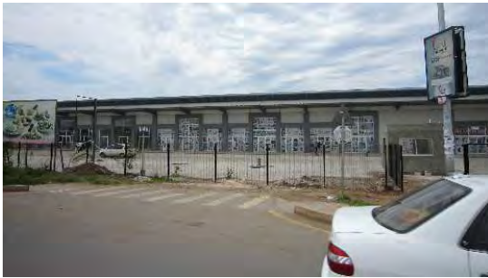
写真：道路沿いに建設中のショッピングモール
