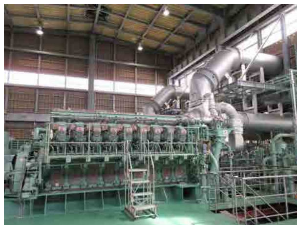
本事業で設置した発電機
