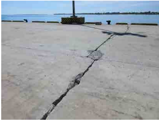
係留棧橋上面部の破損
