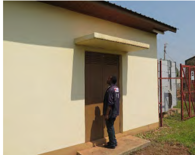
ゴマ配電ポスト (フイエ郡配電網)
