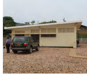
ルインクワブ変電所建屋
