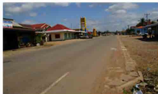
写真2 第二工区終了地点
