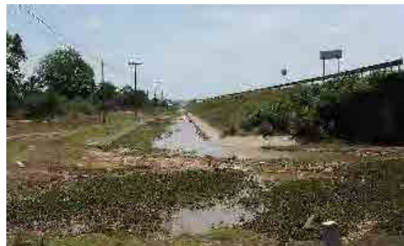
写真 4 国道九号線北側の排水路
