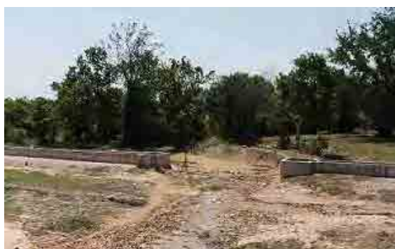
写真5 ホウアイカオ橋下流側の状況
