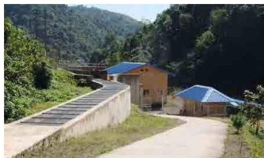
小水力発電所
