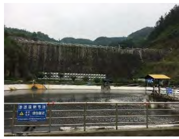
廃棄物処理場の浸出水処理施設
