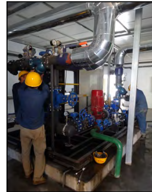
熱交換ステーションのメンテナンス (フフホト市城發投資 経営有限責任公司)
