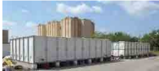
サンフィル消防署の貯水槽
