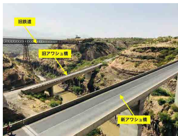
本事業により整備された橋梁 2
