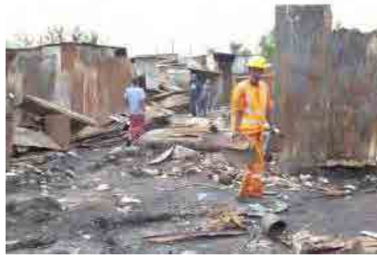
住宅密集地で焼失した 26 軒の後片付け
