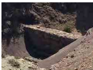
本事業で建設されたチェックダム (AEF 上流域、セフルー県)
