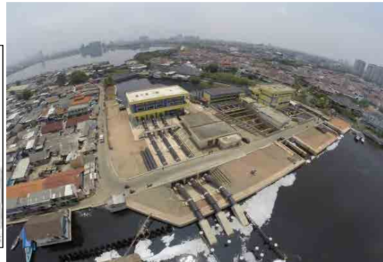
改修後のプリーツ東排水機場 2
