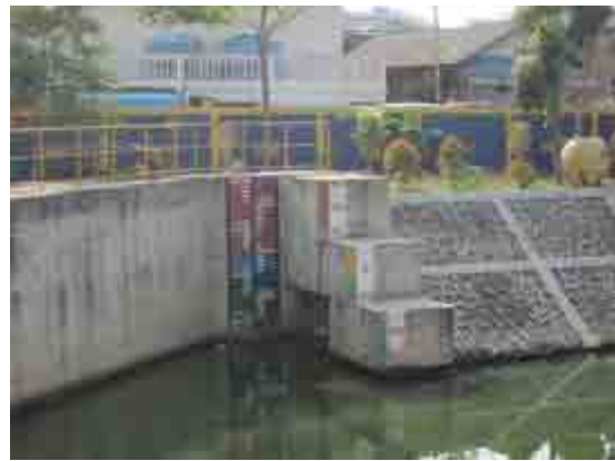
写真4：プルート排水機場 目視で貯水池水位を確認する
