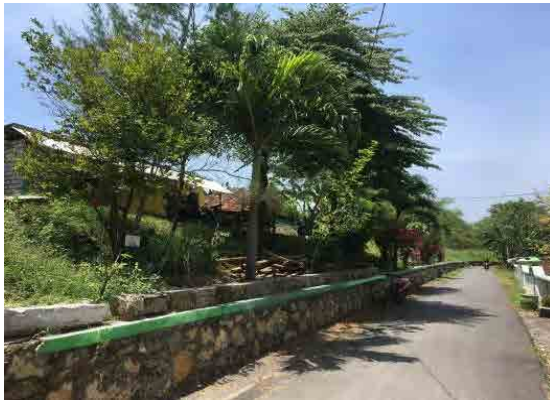
写真3：建設された堤防 (トゥバン地区)
