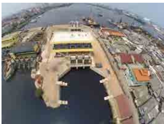
写真 1：改修後の東排水機場全景 8
