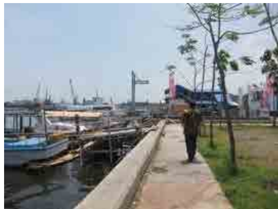
写真 2：改修後の防潮堤西側から
