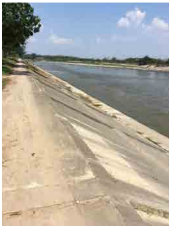
写真 1: ババット堰周辺の護岸壁
